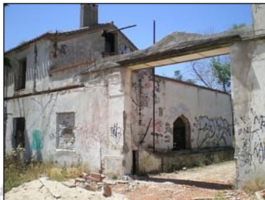
Acceso principal en su estado actual
