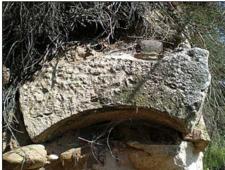
Detalle de la fábrica
