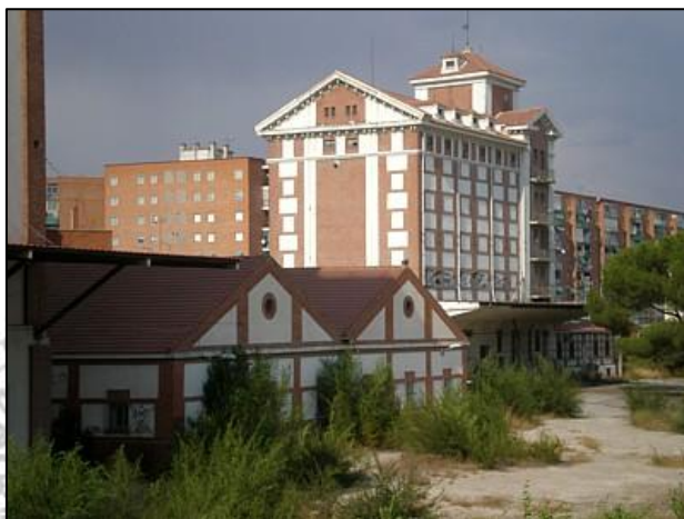
Silo de 1951, vista general
