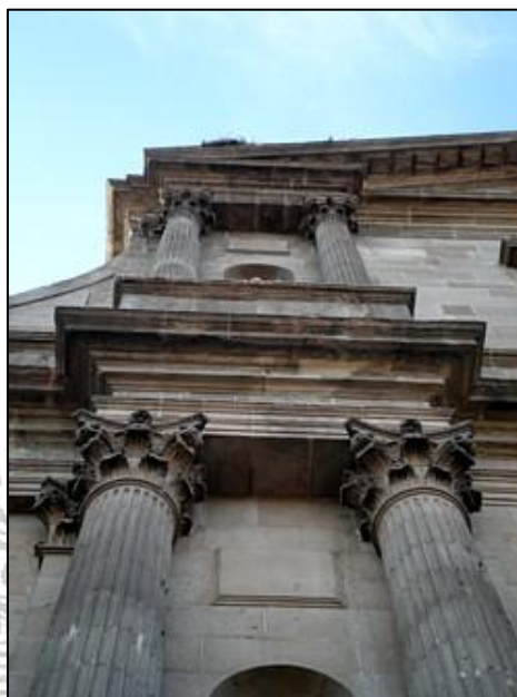
Vista parcial de la fachada
