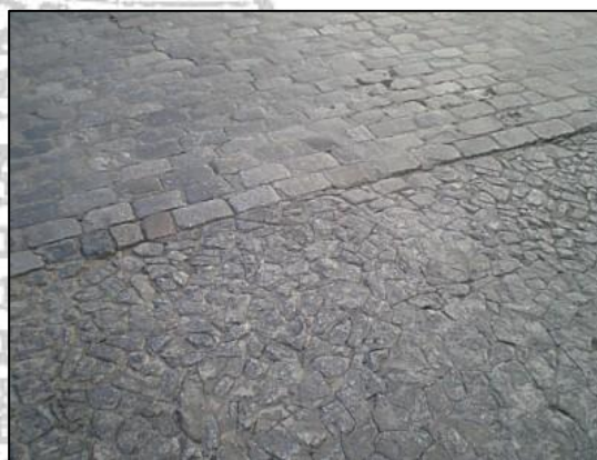
Tramo final a Colegios, cambio de firme
