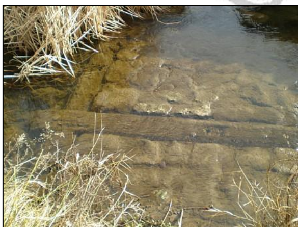
Detalle del entramado bajo las aguas
