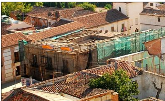
Primer paso: dejarlo sin cubiertas
