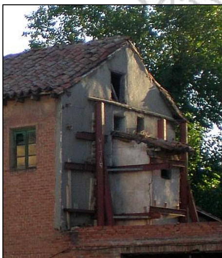
Retrete exterior, en detalle
