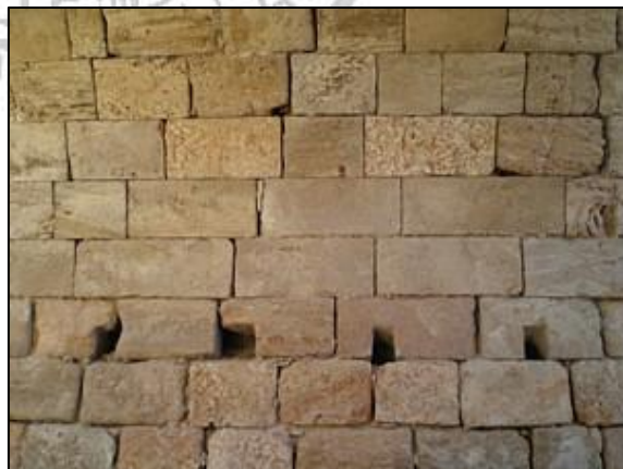
Detalle de los sillares en el arco
