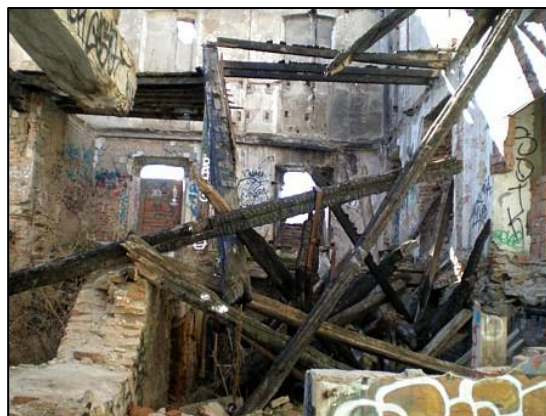
Interior, vigas y estructura
