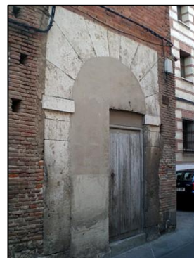
Portada lateral en su actual estado
