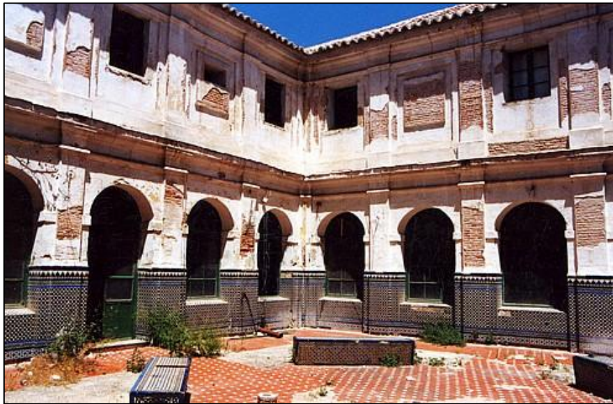
El claustro, en su estado actual
