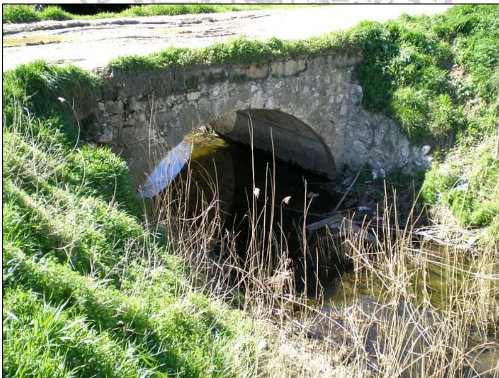
Vista general desde aguas arriba
