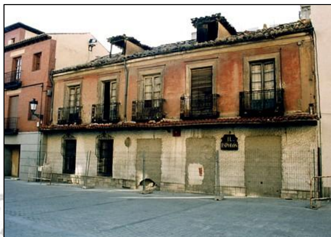
Aspecto antes del derribo
