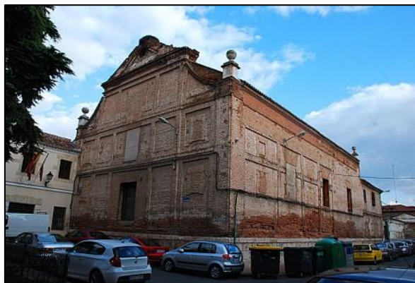
Nave de la iglesia
