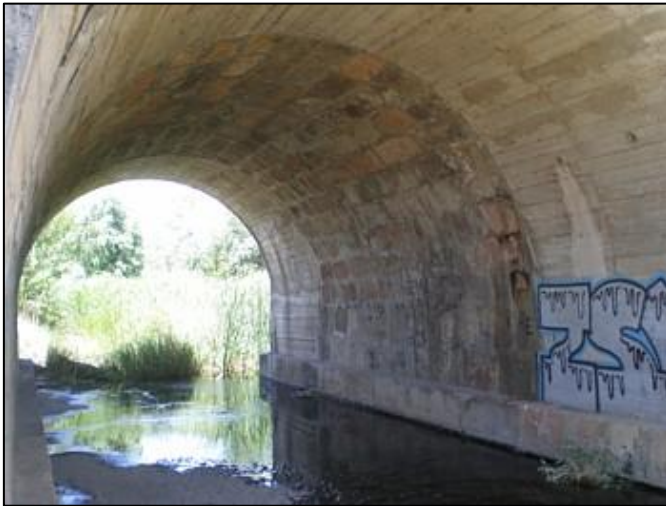
Centro, de sillares; extremos, de hormigón
