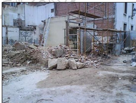
Estado actual: derribo y desolación
