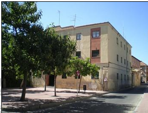
Vista general del edificio actual
