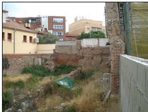
Interior vacío; excavación y restos
