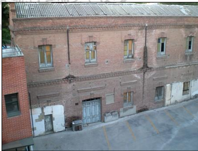
Fachada al patio interior
