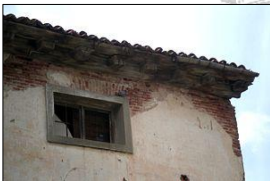
Detalle de fachada y cornisa
