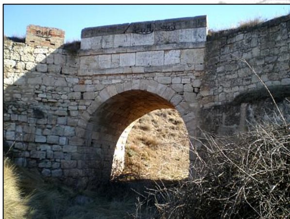
Vista general, 'aguas' abajo
