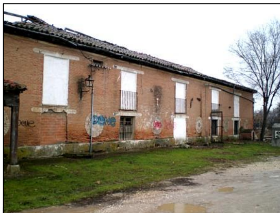
Vista general del molino
