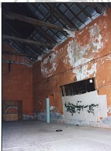
Interior de la nave de la iglesia
