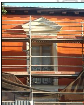
Trabajos de restauración
