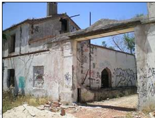
Acceso principal en su estado actual
