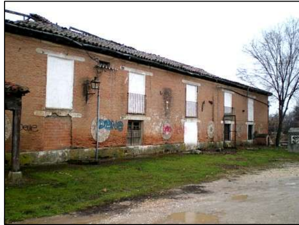
Vista general del molino
