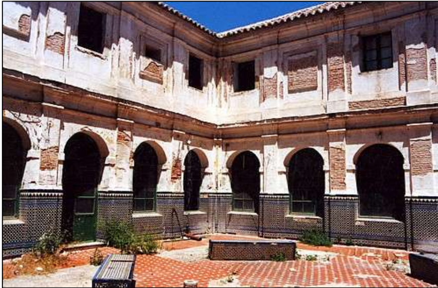
El claustro, en su estado actual
