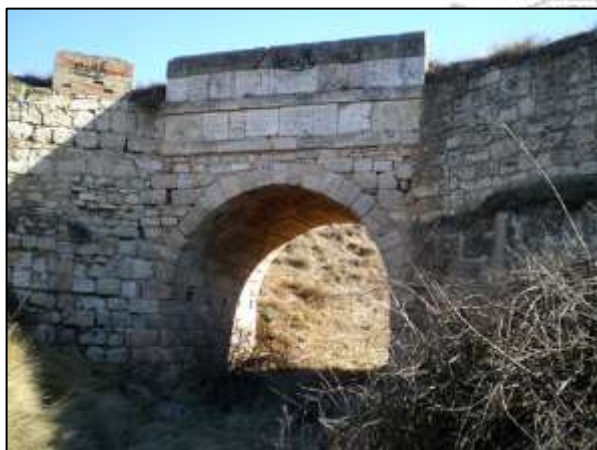
Vista general, 'aguas' abajo
