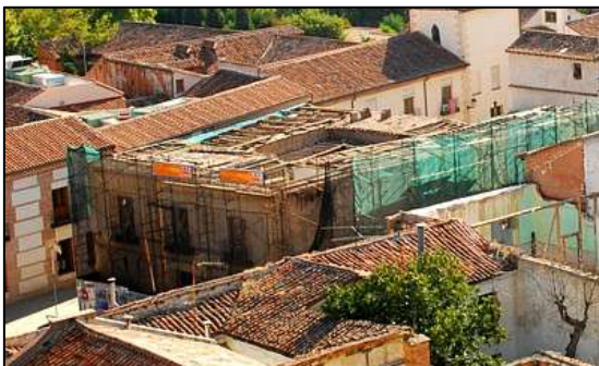
Primer paso: dejarlo sin cubiertas
