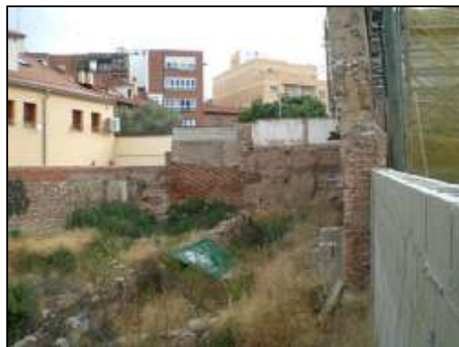
Interior vacío; excavación y restos
