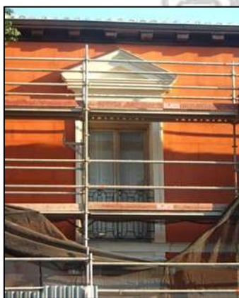
Trabajos de restauración
