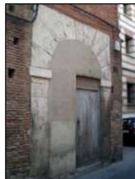
Portada lateral en su actual estado
