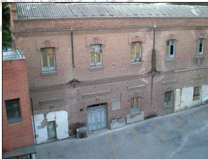
Fachada al patio interior
