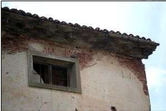
Detalle de fachada y cornisa
