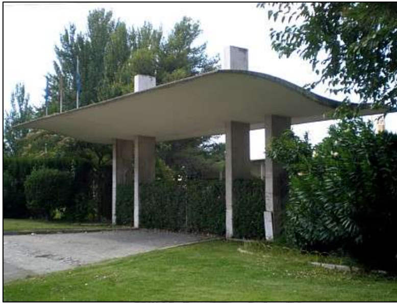
Otra vista más ilustrativa de la estructura
