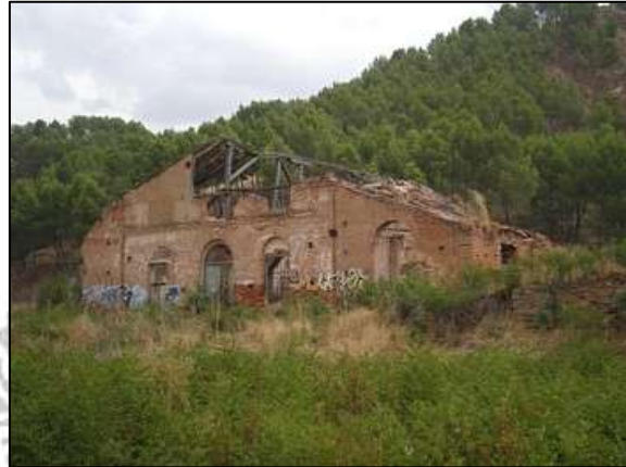
Casa de Los Catalanos
