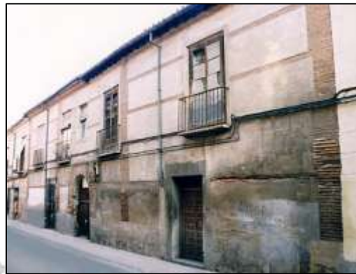
Aspecto antes del 'hundimiento'
