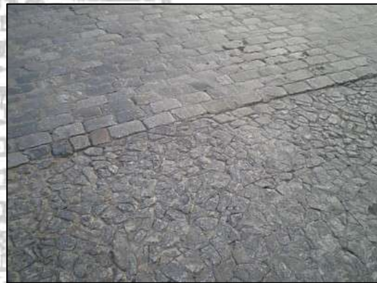
Tramo final a Colegios, cambio de firme
