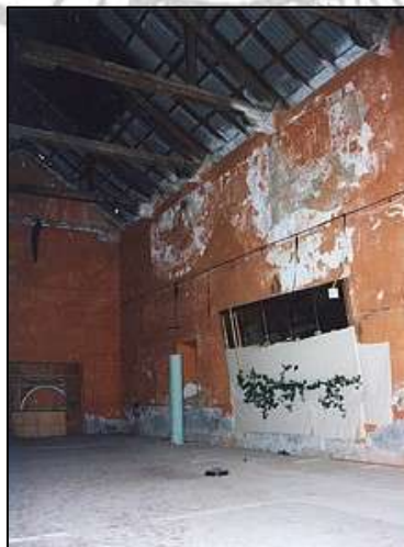
Interior de la nave de la iglesia
