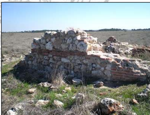
Ladrillo y sillarejo. Pintadas y vandalismo
