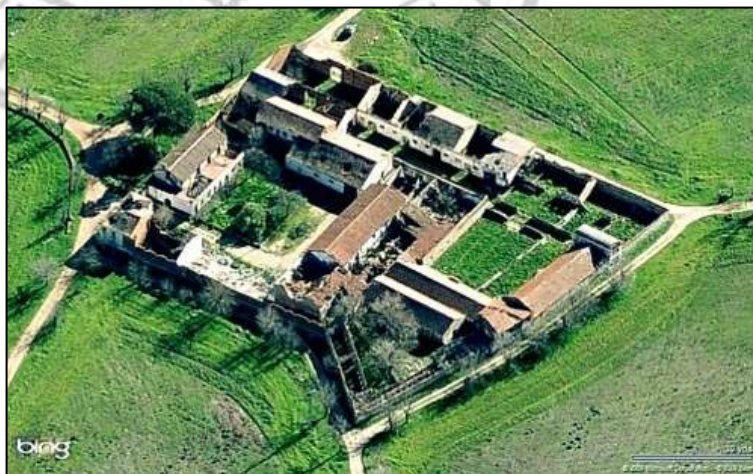
Vista aérea de Espinillos en su conjunto (foto: Bing Maps)
