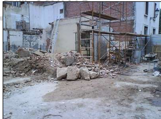
Estado actual: derribo y desolación
