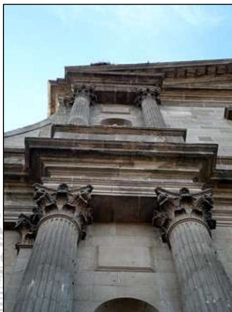
Vista parcial de la fachada
