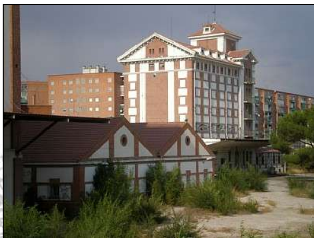
Silo de 1951, vista general
