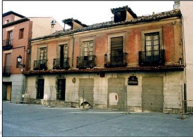
Aspecto antes del derribo
