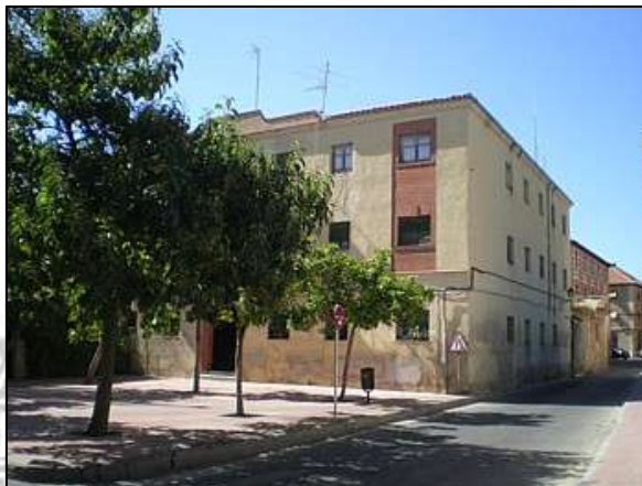
Vista general del edificio actual
