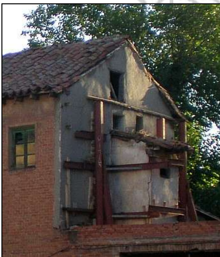
Retrete exterior, en detalle
