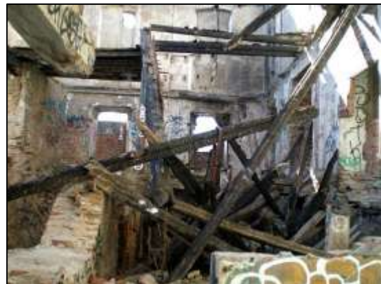
Interior, vigas y estructura
