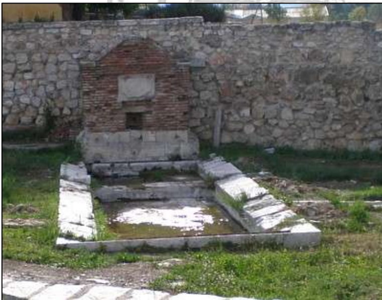
Vista general de la fuente y su estanque
