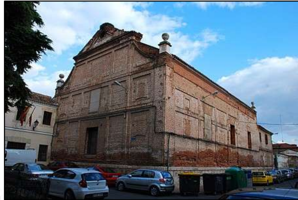
Nave de la iglesia
