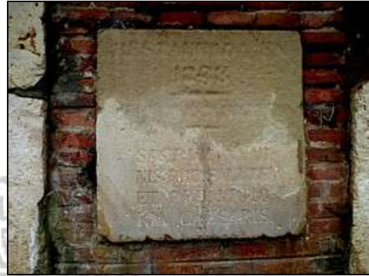
Placa relativa a la restauración del siglo XIX
