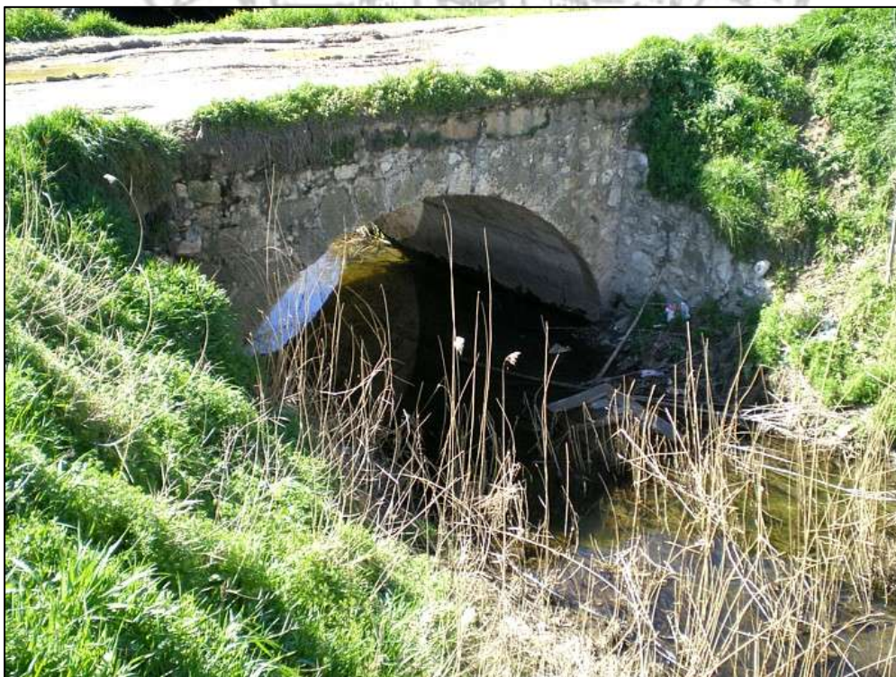
Vista general desde aguas arriba
